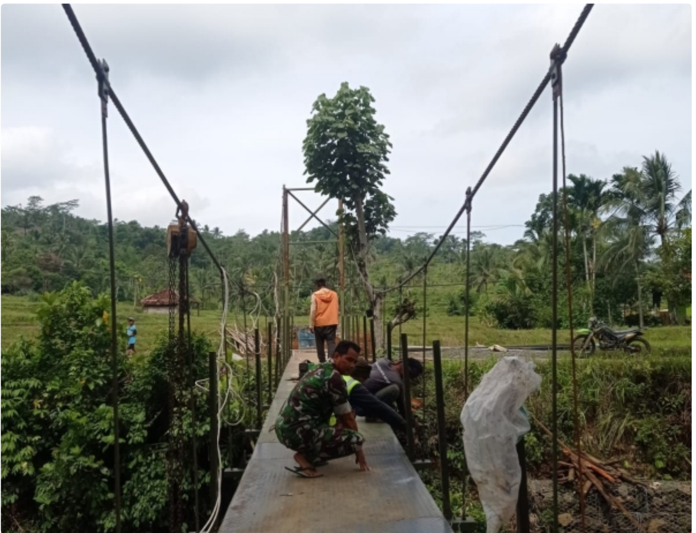
Kpt Arm Witono: Pengerjaan Jembatan Gantung Sudah 80%
