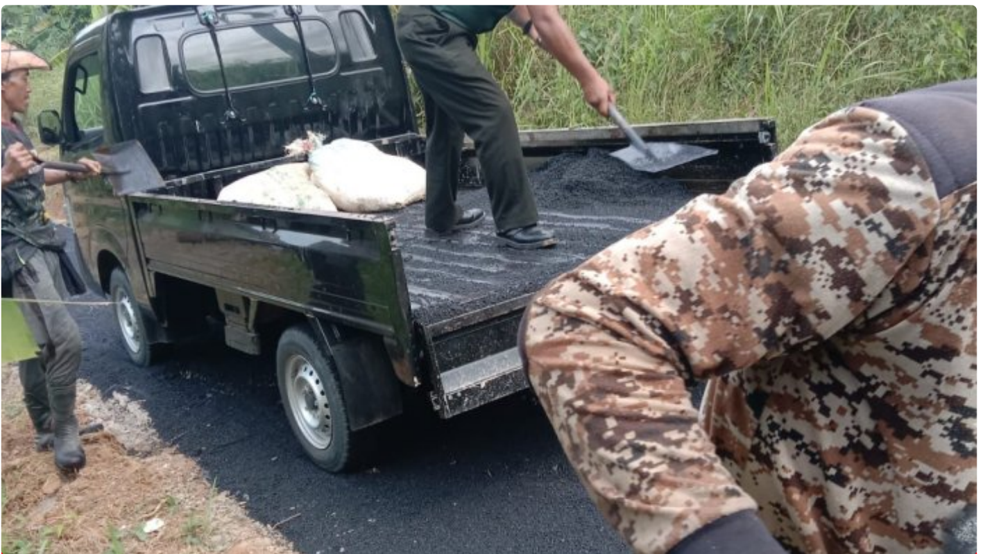
Koramil 0622-04/Cikidang Monitor Pembangunan Jalan ADD Sepanjang 400 M
