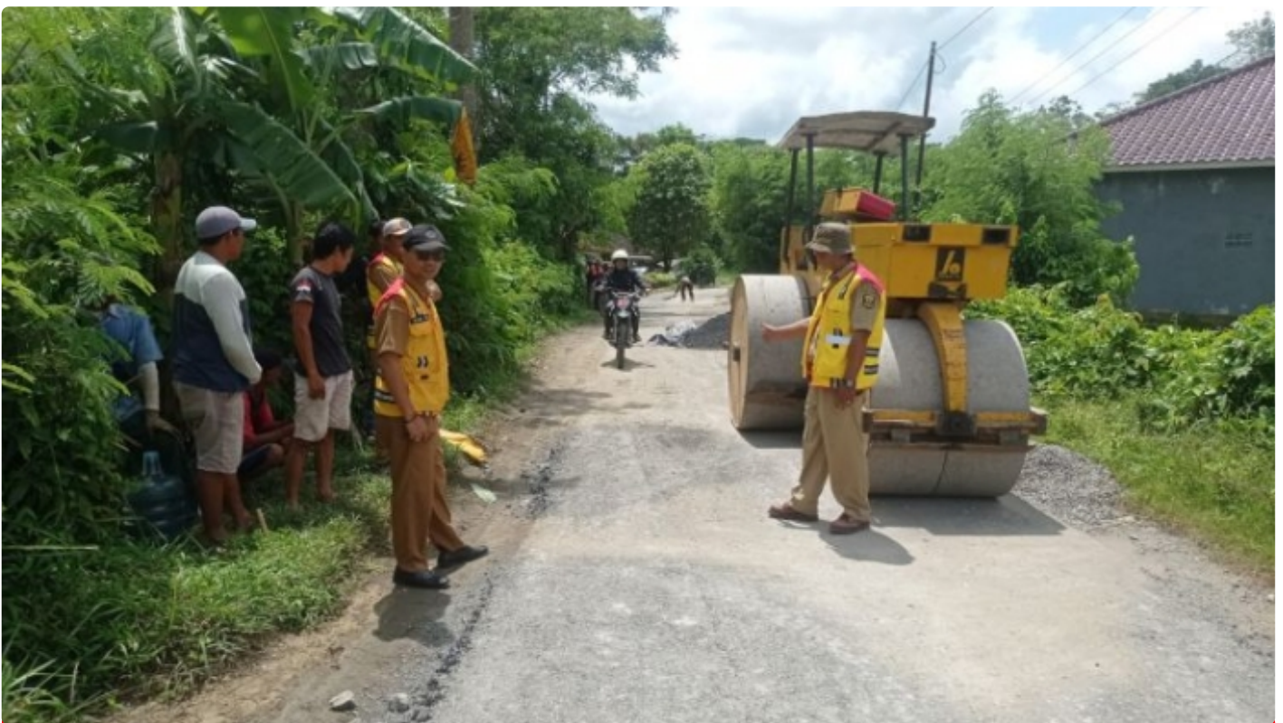
Dinas PU Kabupaten Sukabumi Perbaiki Jalan Rusak di Wilayah Jampangkulon.
