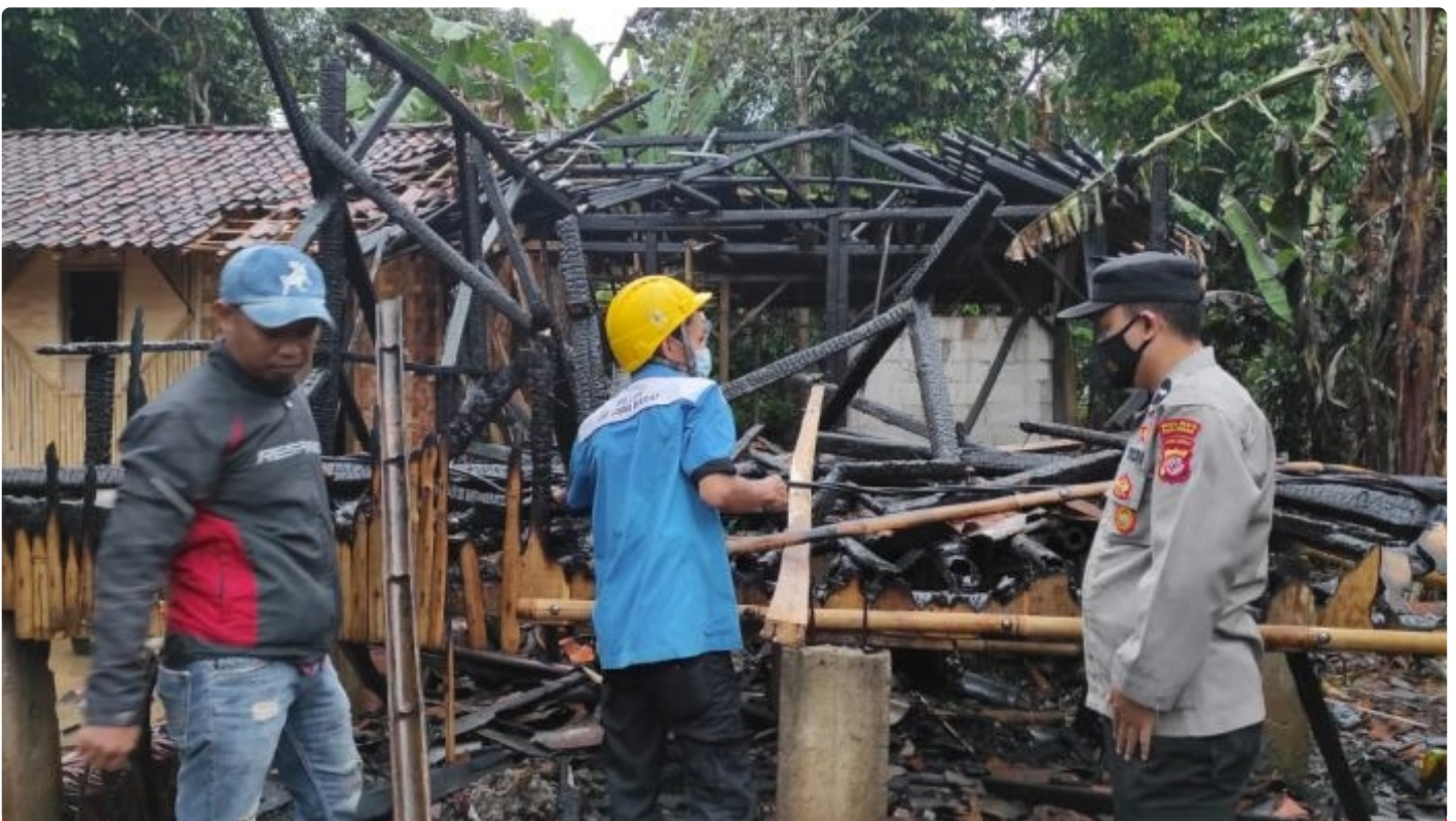
Diduga Akibat Konsleting Listrik Sebuah Pesantren Hangus Terbakar
