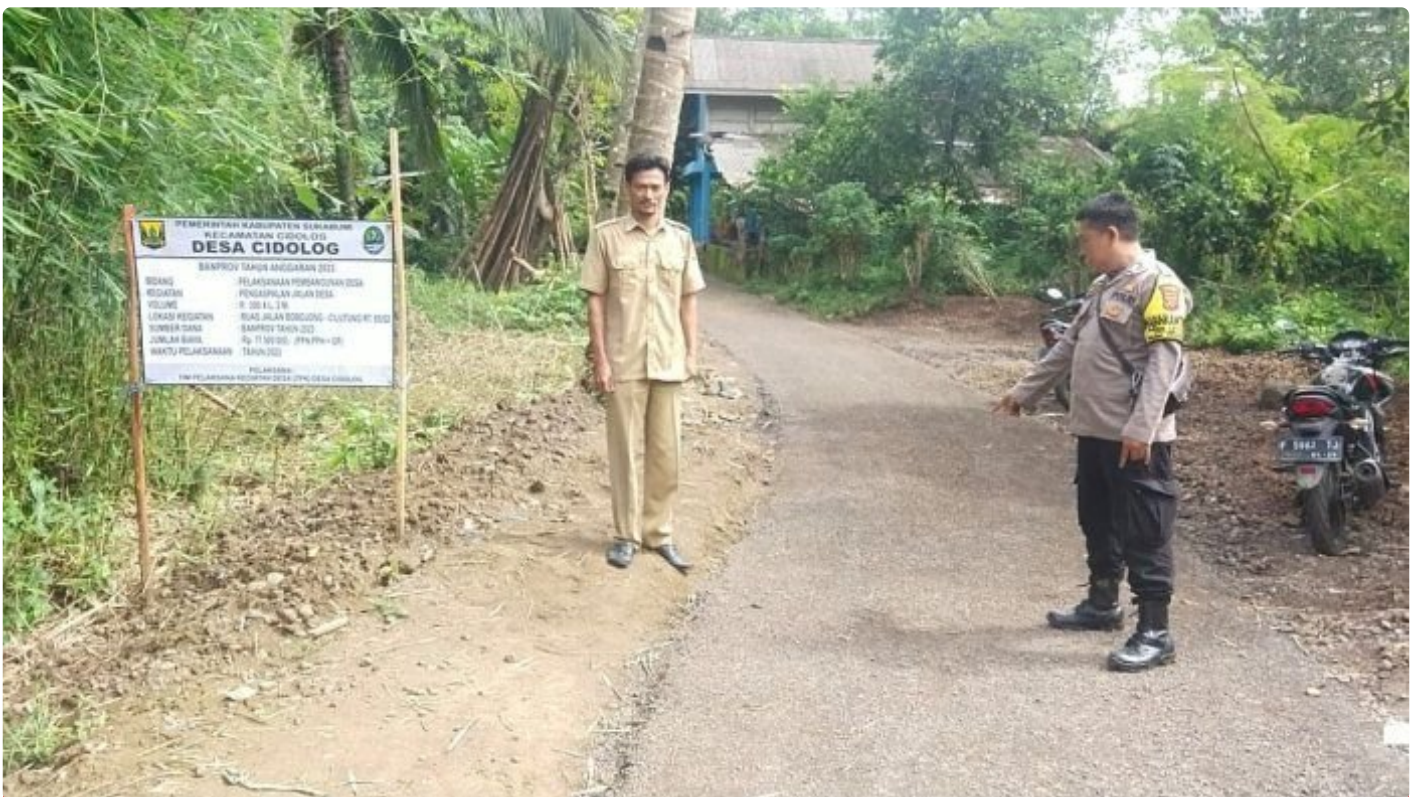
Bhabinkamtibmas Desa Cidolog Awasi Pembangunan Desa
